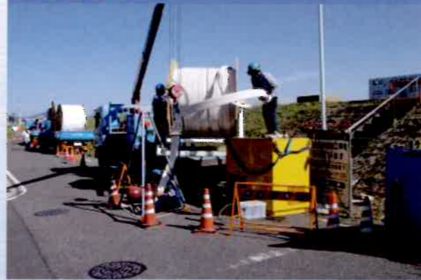
施工中 (愛知県)
