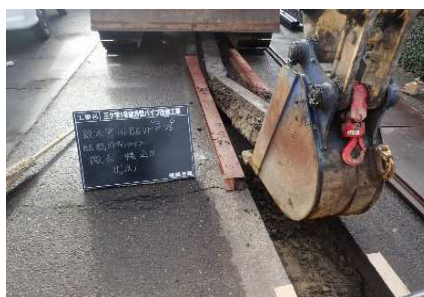
【施工中工事写真】
